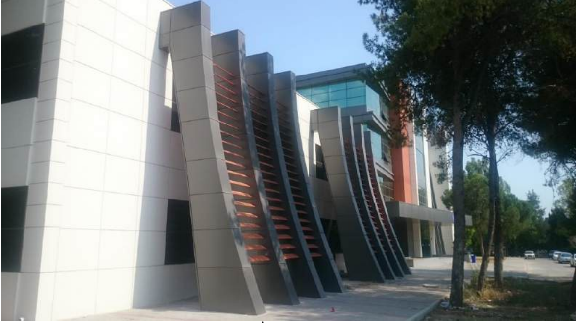
Resim-İş Atölyesi Binası
