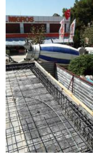
1.kat zemin kalıp işleri
