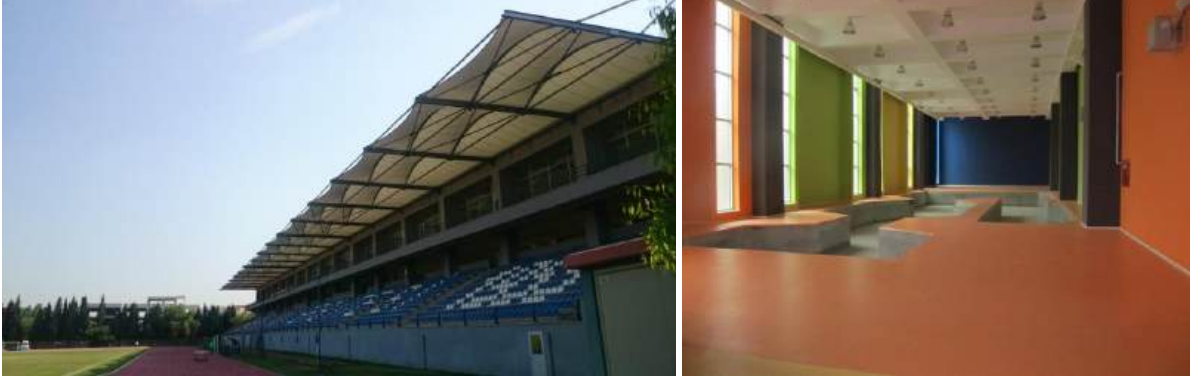
Kapalı Tribün Binası
