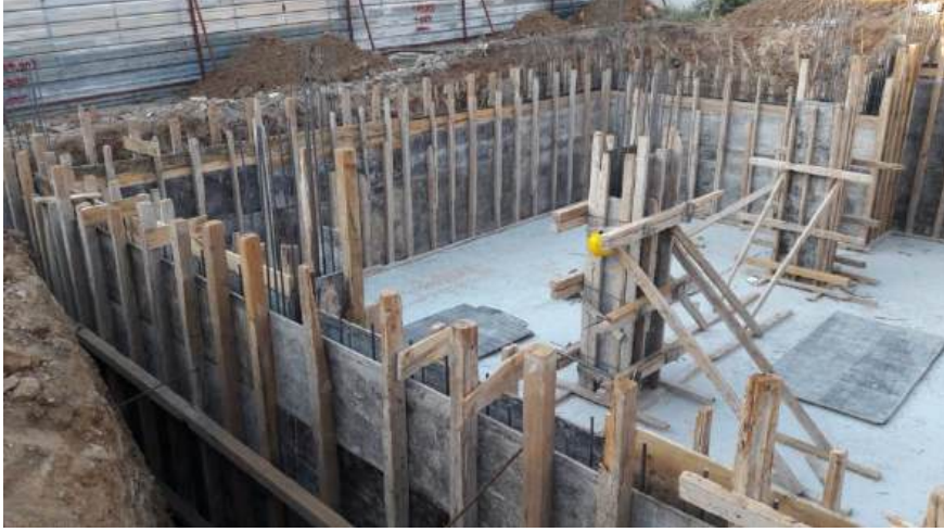
Bodrum kat perde kalıp ve beton dökümü işleri
